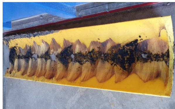
Abb. 5: abgeschleuete Schneckenführung der Schlammförderanlage
