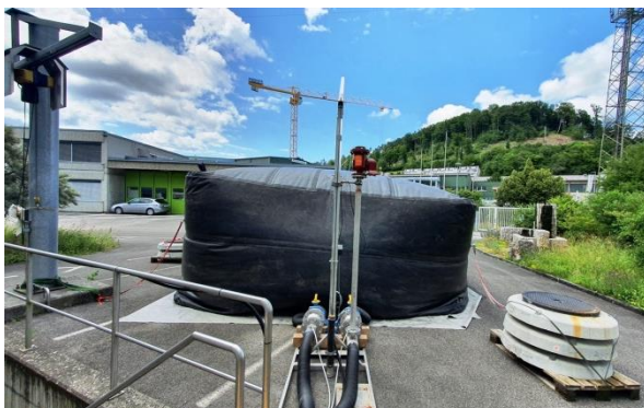
Abb. 4: provisorischer Gasometer während der Revisionsarbeiten
